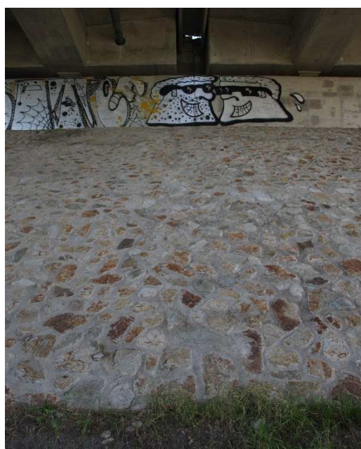
Obr. 2.5 Spevnenie svahového kužela pod mostom
